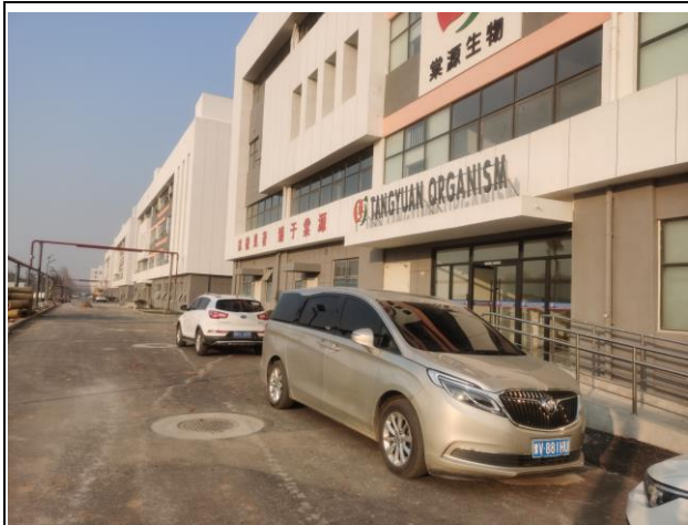
项目厂房外部
