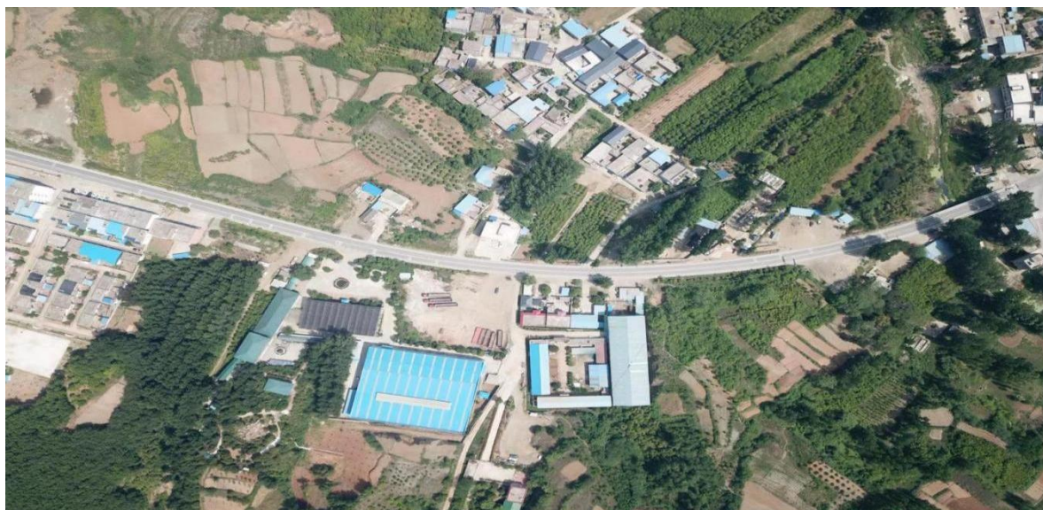
图 2：事故现场照（无人机俯瞰拍摄）
