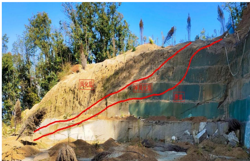
图 2.2-1 风化、半风化及原岩对比照片
