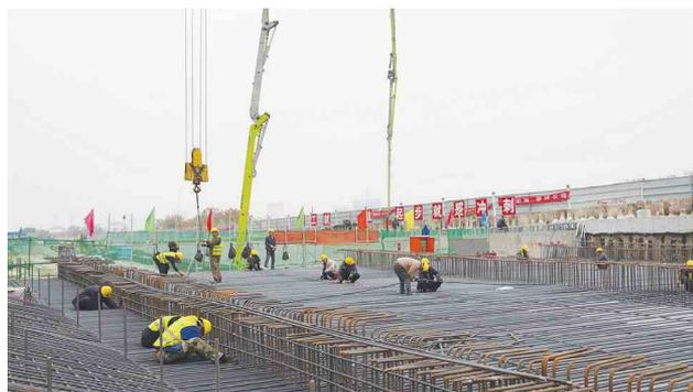
在中心城区滨河大道下穿仲景大道工程基础底板钢筋绑扎现场（赵洋 谢康 摄）
