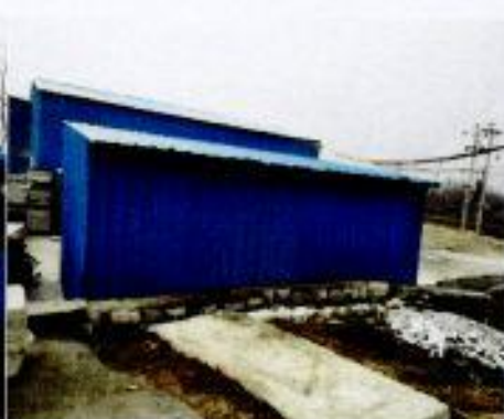
生产车间封闭
