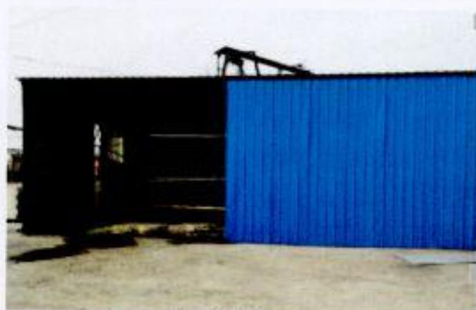
抛光车间封闭
