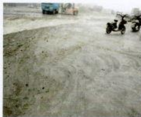
厂区路面硬化
