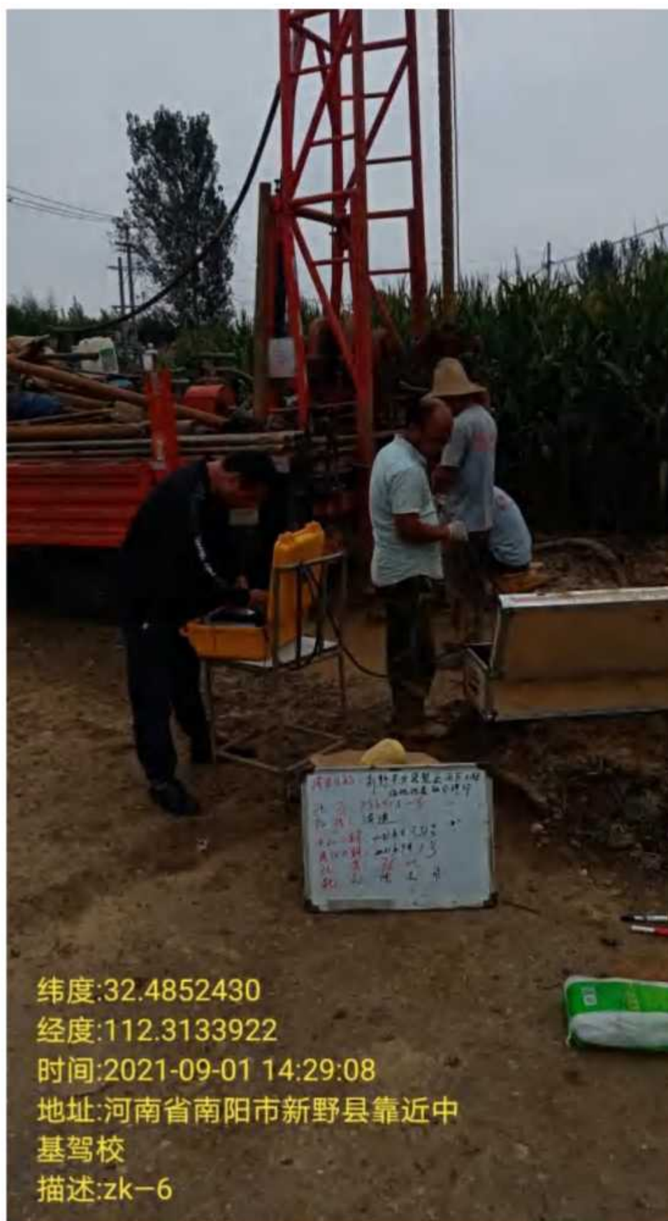
图 11 工程场地 6 号钻孔现场工作照
