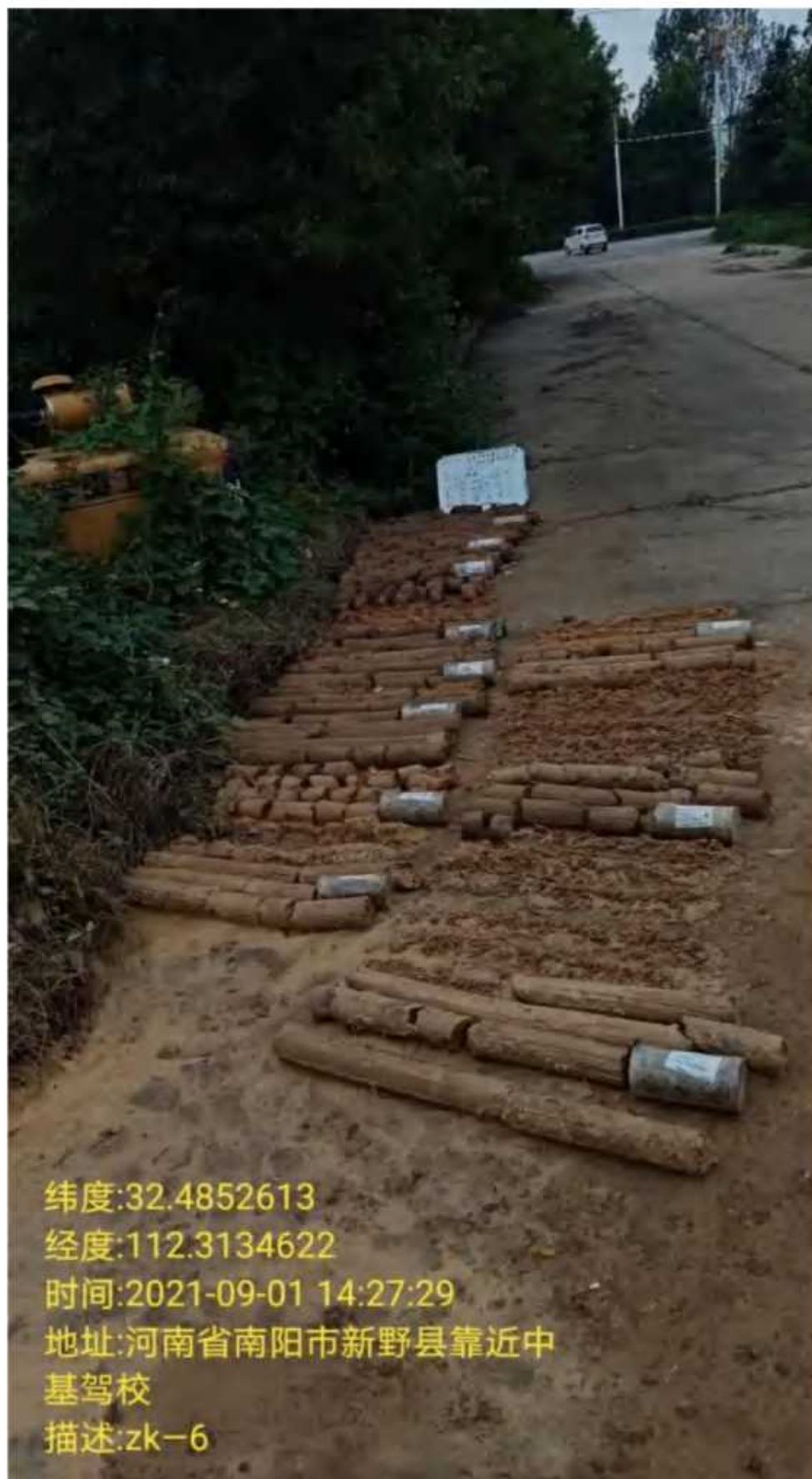
图 12 工程场地 6 号钻孔现场工作照
