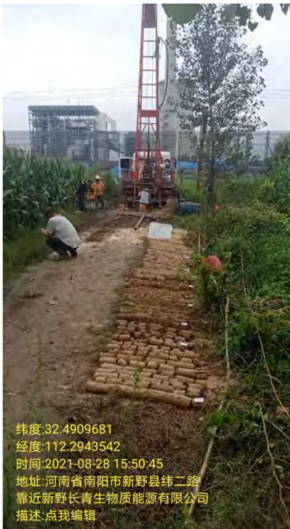
图 3 工程场地 2 号钻孔现场工作照
