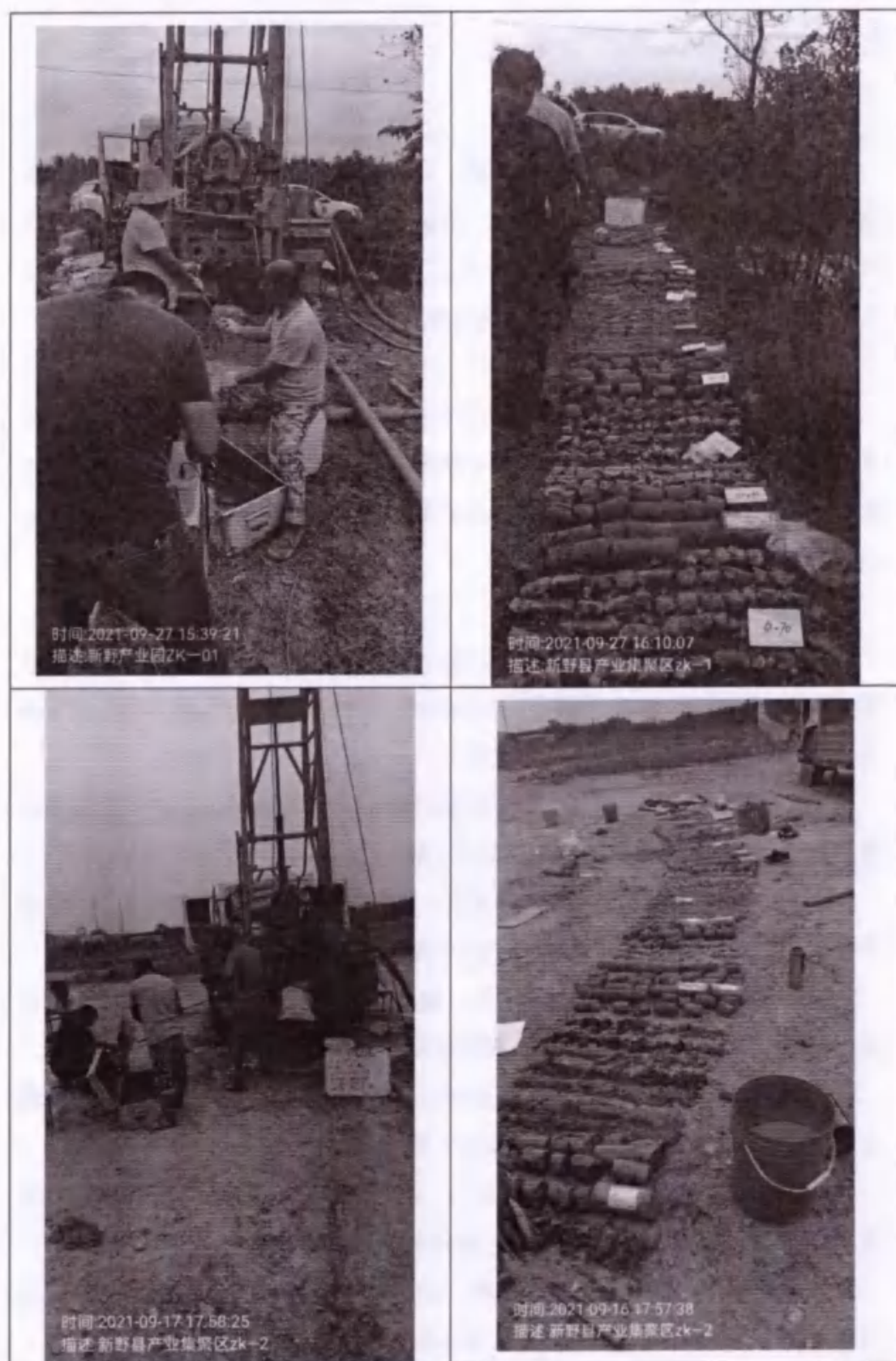
图 5.0-2 地震钻孔现场施工、岩芯、波速测试工作照（部分）
