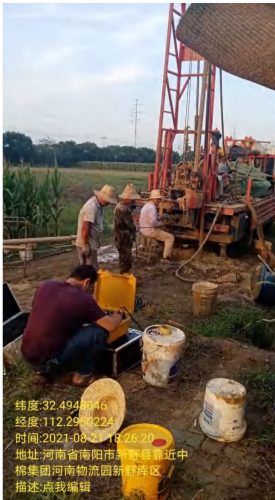
图 1 工程场地 1 号钻孔现场工作照
