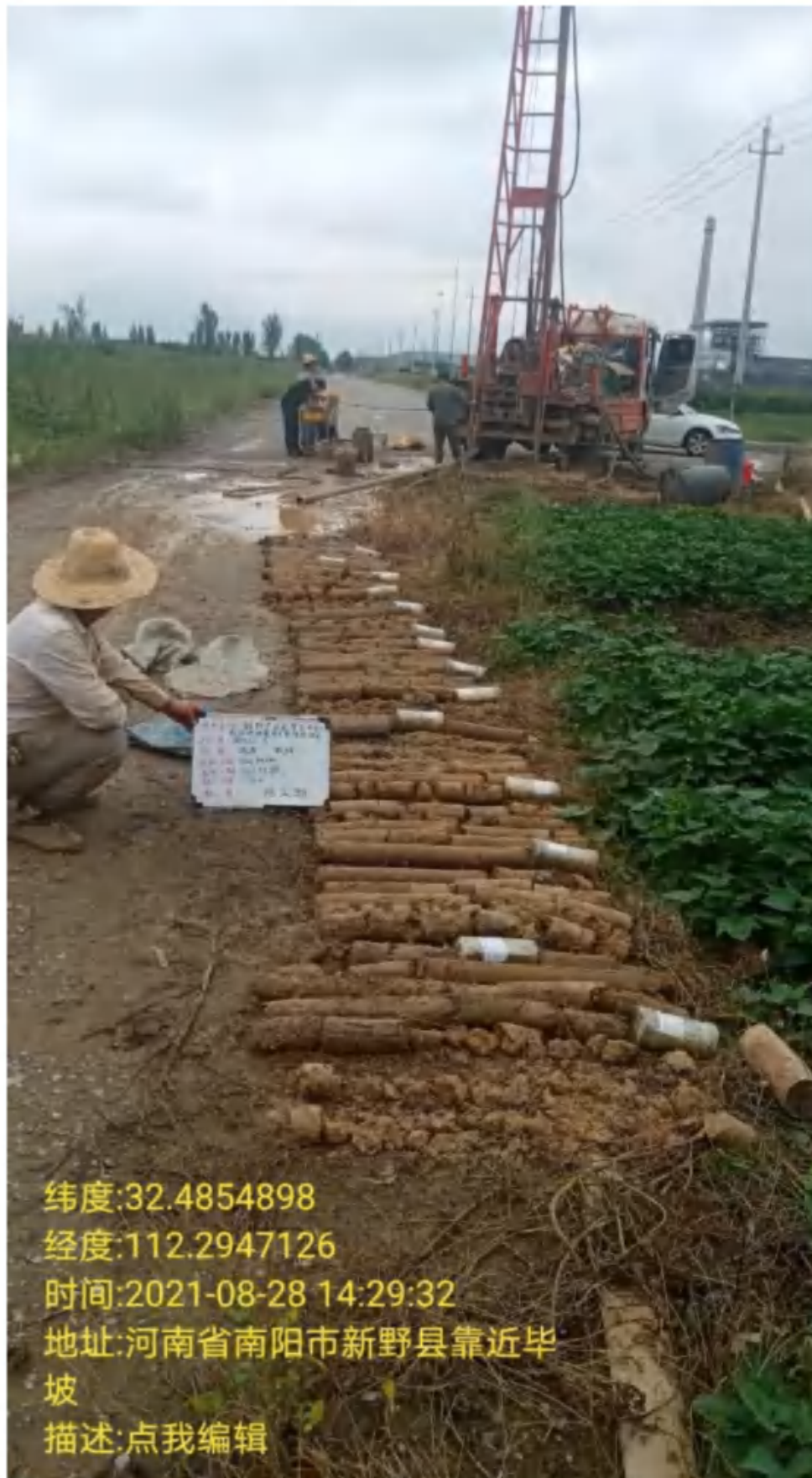
图 6 工程场地 3 号钻孔现场工作照
