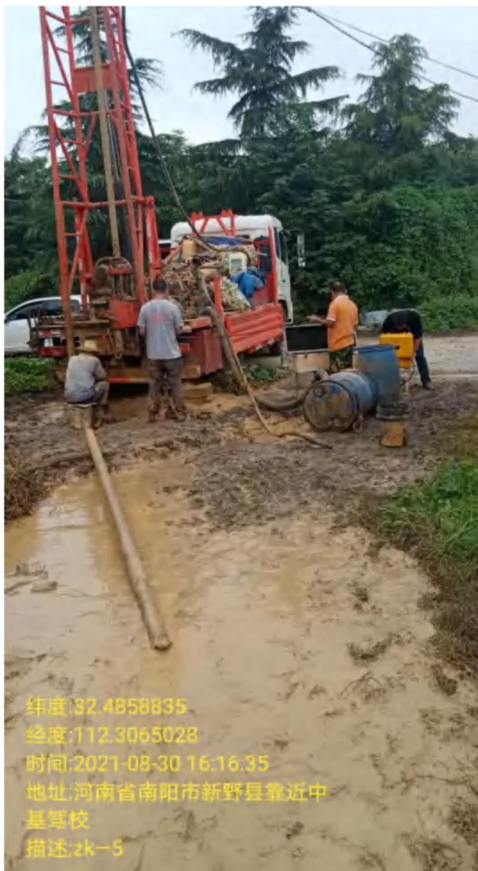
图 9 工程场地 5 号钻孔现场工作照
