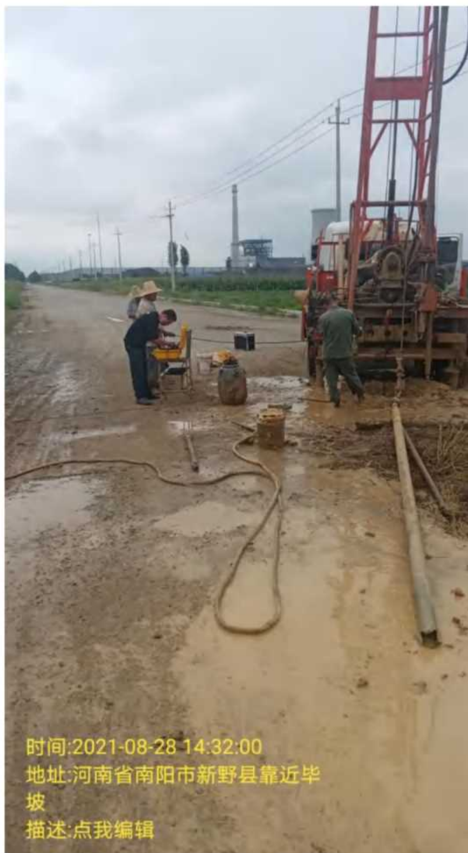
图 5 工程场地 3 号钻孔现场工作照
