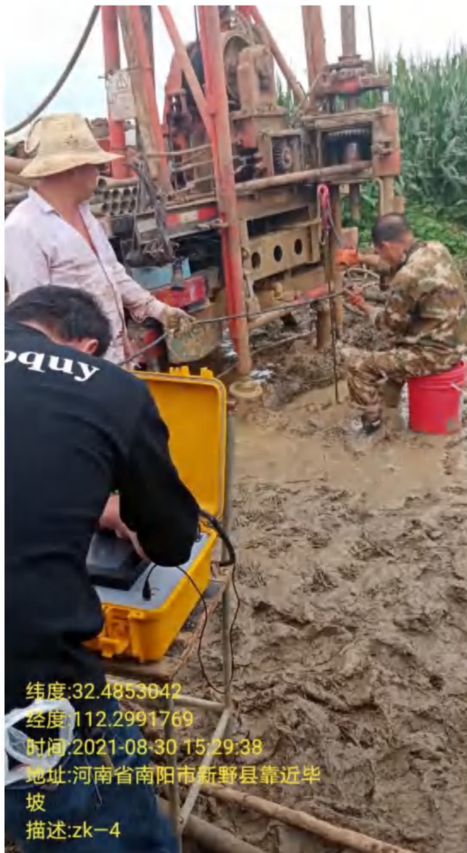
图 7 工程场地 4 号钻孔现场工作照
